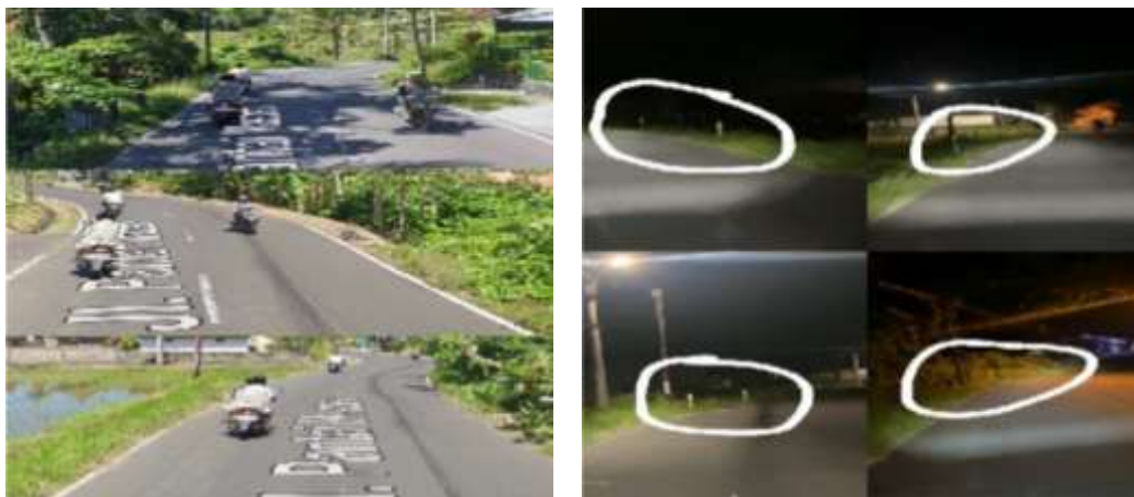
Gambar 6. Kondisi jalanan sebelum dan sesudah pemasangan reflektor jalan
