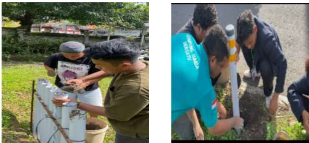
Gambar 5. Melakukan pengecoran dan pemasangan pada pipa reflector
