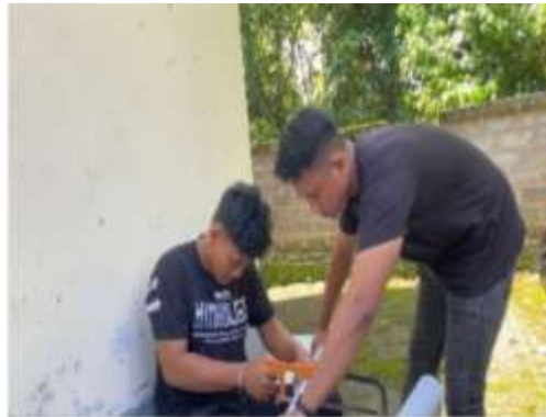
Gambar 3. Melakukan pemotongan pipa untuk reflektor jalan
