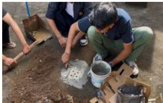
Gambar 1. Proses Pembuatan Lubang Resapan Biopori
